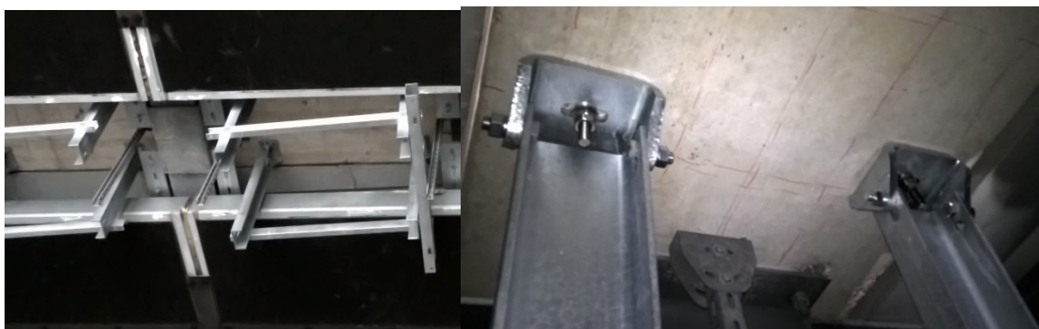
Figure 42: Ancrage des châssis des accélérateurs et des pendants des chemins de câbles dans la structure avant repose des écrans acoustiques
