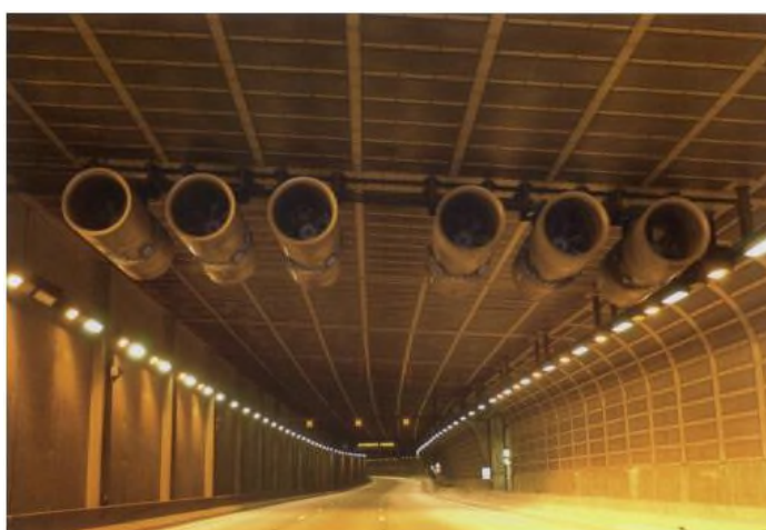
Figure 8: Treillis de pannes, faitières, protection phonique, portiques et accélérateurs
